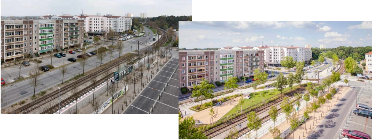
Abbildung 57: Umbau der Konrad-Wolf-Allee in Potsdam. (Quelle: UBA 2017)
