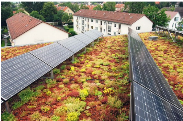
Abbildung 33: Extensive Dachbegrünung mit PV-Anlage (oben) und intensive Dachbegrünung (unten) (Quelle: Stadt Münster o.J., Paul Bauder GmbH & Co. KG o.J.).
