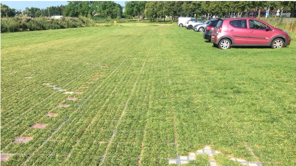
Abbildung 65: Wasserdurchlässige Befestigung eines Parkplatzes in Edam, NL. Quelle: eigene Aufnahme (2021).
