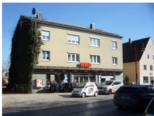
Abbildung 57: Beispiel Wohn- und Geschäftshaus mit flachem Satteldach, Augsburger Straße 4a
