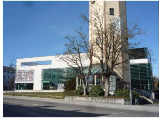
Abbildung 60: Beispiel Gebäude mit Flachdach, Ballonmuseum, Bahnhofstr. 12
