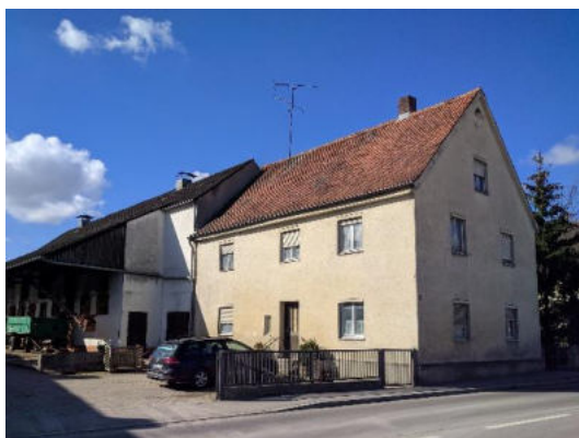
Abbildung 68: Beispiel Gebäude mit mittlerem Sanierungsbedarf, Kirchstr. 13
