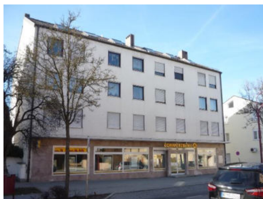
Abbildung 67: Beispiel Gebäude mit geringem Sanierungsbedarf, Augsburger Str. 7
