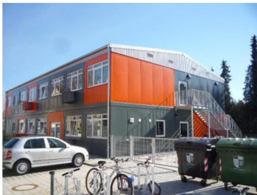
Abbildung 79: Pestalozzstraße 11, temporäre Schulerweiterung
