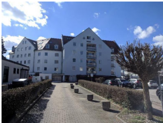
Abbildung 97: Durchgang zwischen Parkplatz und Rotkreuzstraße 7
