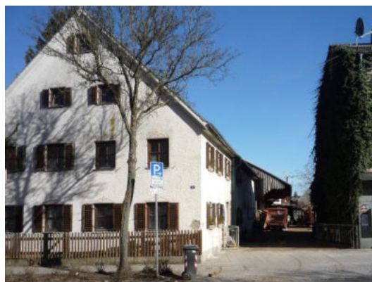
Abbildung 69: Beispiel Gebäude mit hohem Sanierungsbedarf, Augsburger Str. 4
