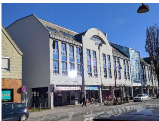
Abbildung 66: Beispiel Gebäude ohne Sanierungsbedarf, Donauwörther Str. 3
