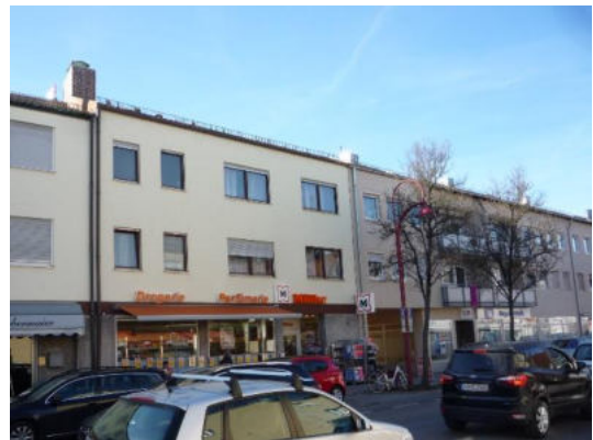
Abbildung 73: Beispiel Gebäude mit hohem Gestaltungsbedarf, Augsburgstr. 3 & 5
