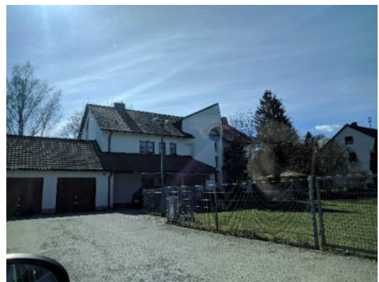
Abbildung 85: eingezäunte Fl.nr. 1043 und Bgm.-Wendler-Str. 21
