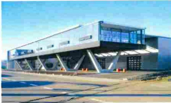
Abbildung 248: Beispiel eines aufgeständertes Verwaltungsgebäude mit darunterliegendem Rangierraum und Parkierungsflächen, Kreuer Edelstahl GmbH
