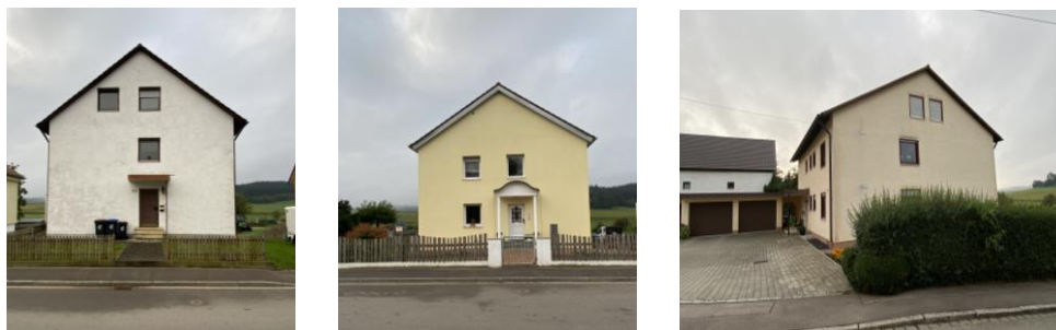
Abb. 6: vorhandene Bestandsgebäude mit zum „Gebäudetyp B“ vergleichbarer Ausprägung
