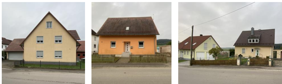
Abb. 5: vorhandene Bestandsgebäude mit zum „Gebäudetyp A“ vergleichbarer Ausprägung
