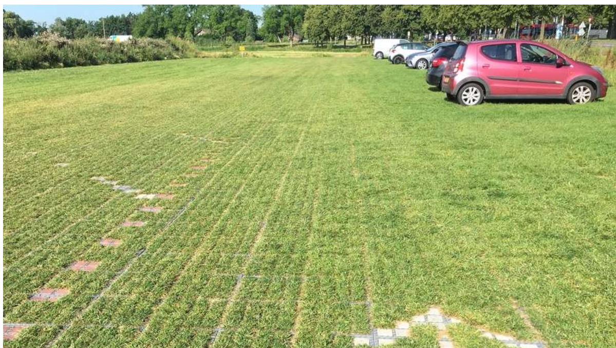
Abbildung 65: Wasserdurchlässige Befestigung eines Parkplatzes in Edam, NL. Quelle: eigene Aufnahme (2021).
