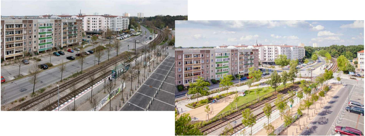
Abbildung 57: Umbau der Konrad-Wolf-Allee in Potsdam. (Quelle: UBA 2017)
