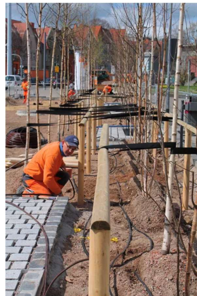
Abbildung 37: Anlage eines Bewässerungssystems mit Tröpfchenbewässerung und unterirdischer Wasserbevorratung für neu gepflanzte Bäume. (Quelle: ThINK 2021)
